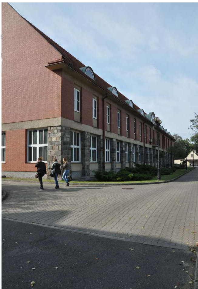
Fot. 5 – Istniejący budynek biblioteki przy ul. Chodkiewicza 30 w Bydgoszczy.
