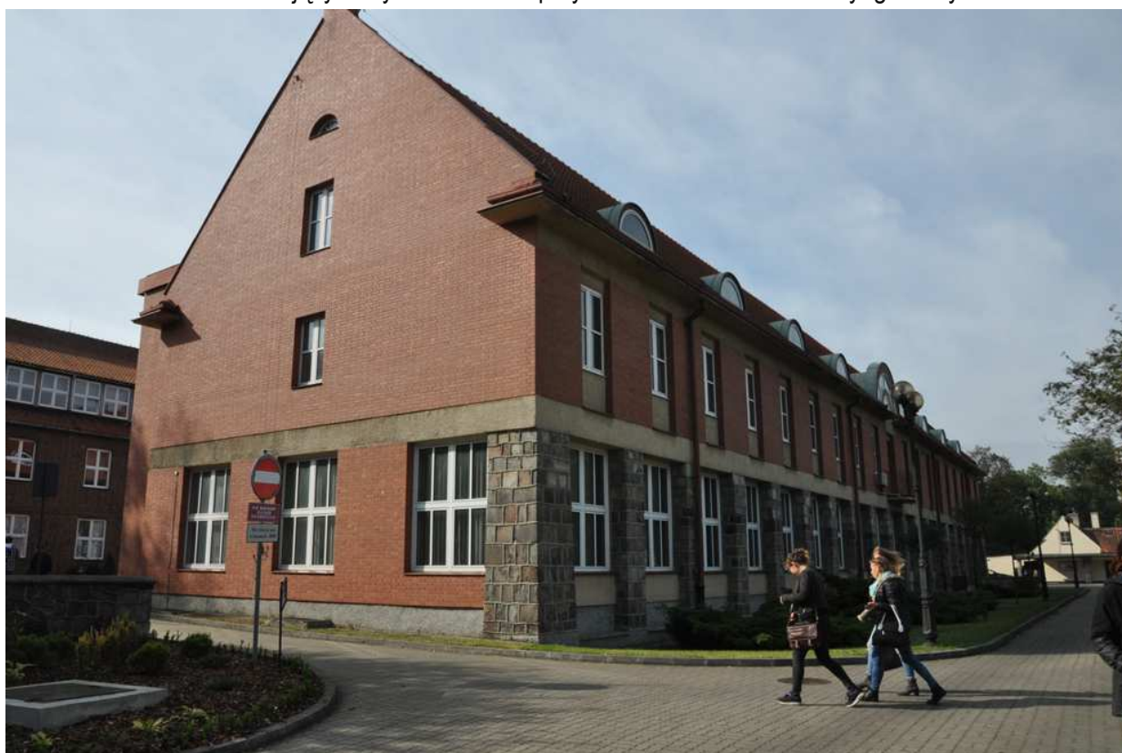
Fot. 2 – Istniejący budynek biblioteki przy ul. Chodkiewicza 30 w Bydgoszczy.
