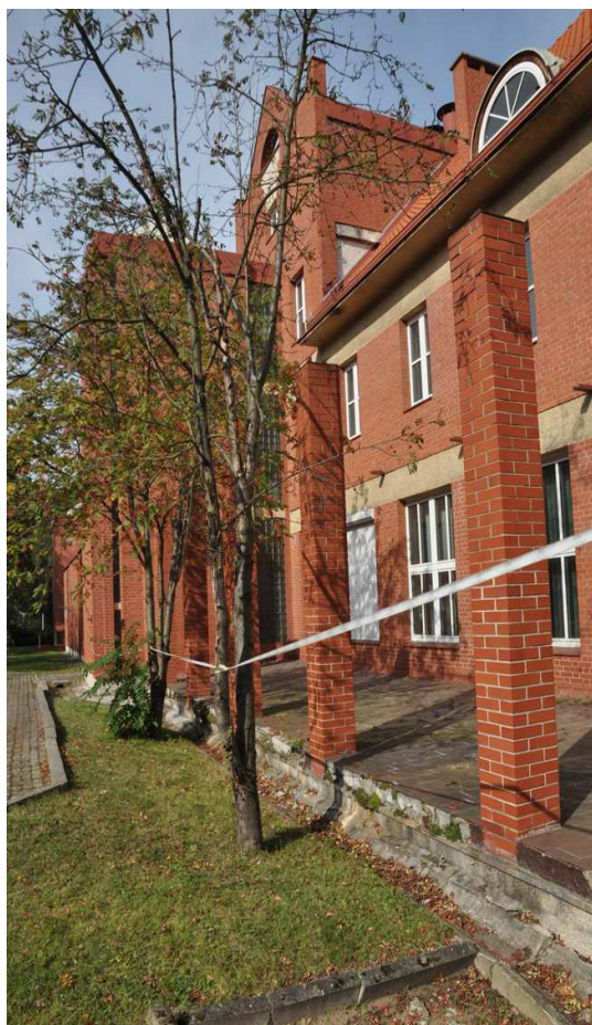
Fot. 3 – Istniejący budynek biblioteki przy ul. Chodkiewicza 30 w Bydgoszczy.
