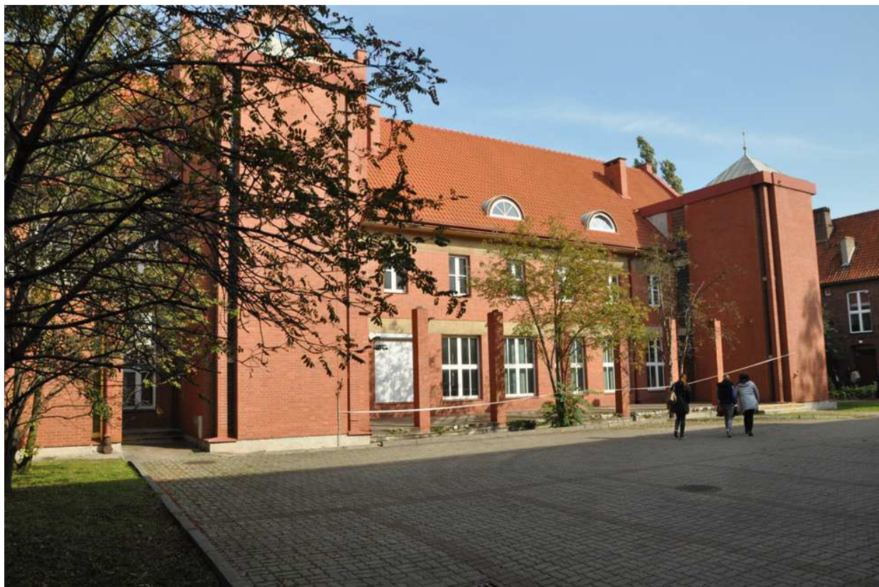
Fot. 1 – Istniejący budynek biblioteki przy ul. Chodkiewicza 30 w Bydgoszczy.
