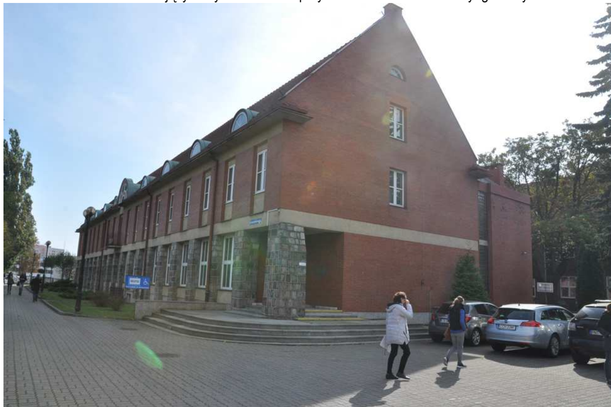
Fot. 4 – Istniejący budynek biblioteki przy ul. Chodkiewicza 30 w Bydgoszczy.
