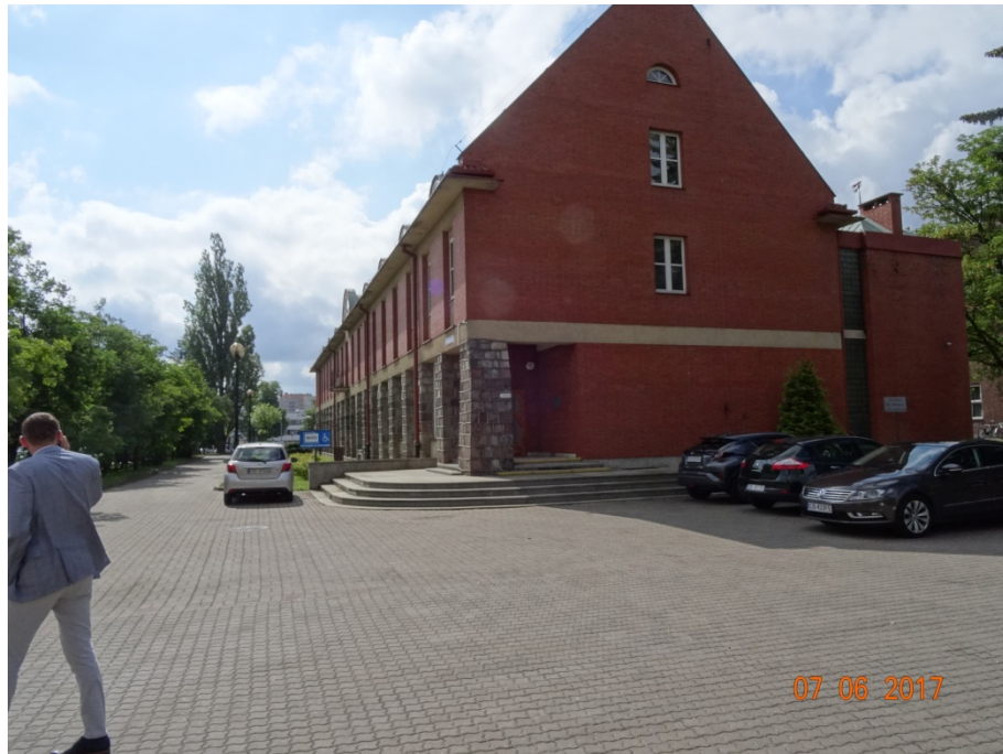
Fot. 1. Widok obiektu od strony północno wschodniej. Widoczna ściana frontowa z charakterystycznymi słupami z granitowych bloków ciosanych w poziomie parteru oraz prawa ściana szczytowa z dobudowaną dwukondygnacyjną częścią sanitarną.
