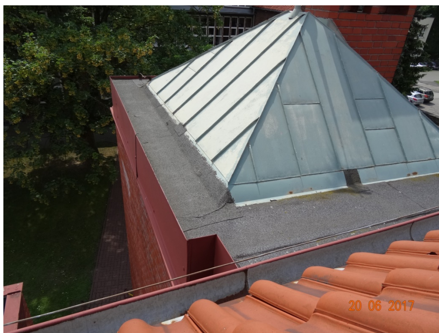
Fot. 28. Dach dwukondygnacyjnej części sanitarnej (fotografia wykonana przez okno na poddaszu użytkowym budynku zasadniczego). Ostrosłupowa część dachu pokryta blachą na rąbki stojące i leżące. Poziome fragmenty dachu pokryte papą na pierwotnym pokryciu blaszanym. Brak prawidłowego połączenia papy z blachą pokrywającą części skośne dachu. Brak prawidłowego połączenia pokrycia papowego z pionowymi blachami czołowymi skutkujące uszkodzeniami ściany widocznymi na fot. 24 i 25.
