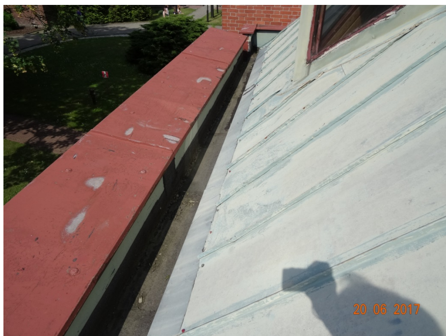
Fot. 34. Dach części parterowej. Koryto zewnętrzne uszczelnione papą. Pas nadokapowy wymieniony – połączenia na blachowkręty.
