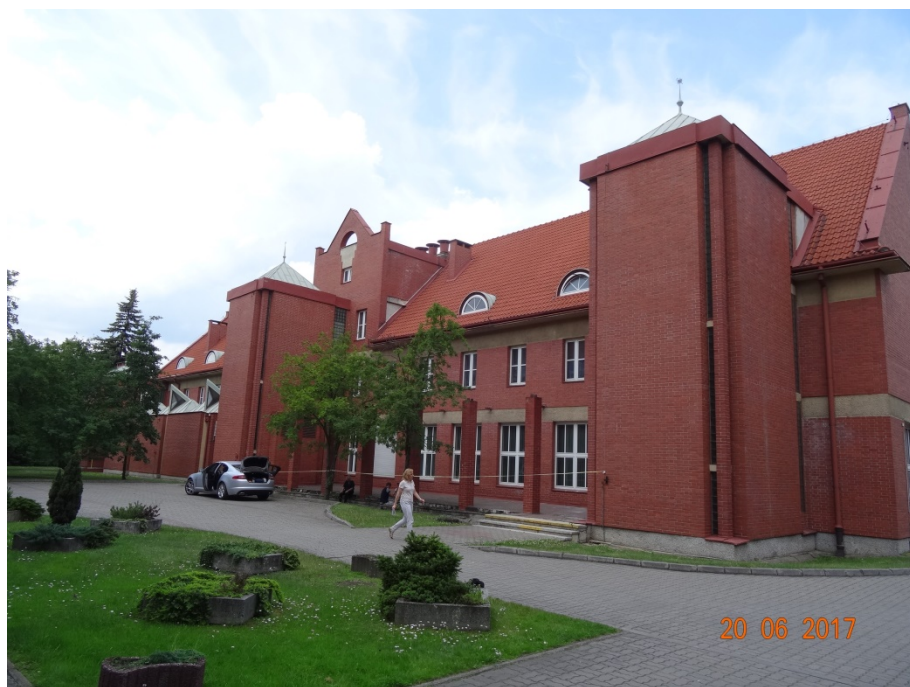
Fot. 2. Ściana tylna obiektu. Na tle ściany budynku zasadniczego z wystawką w poziomie dachu widoczne dwie dobudowane klatki schodowe rozdzielone tarasem z murowanymi słupkami dawniejszej pergoli oraz fragment parterowej części z charakterystycznymi naświetlami na dachu.
