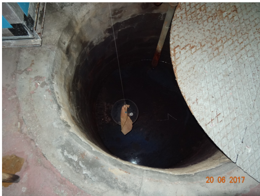
Fot. 66. Wentylatornia. Studnia odwadniająca.
