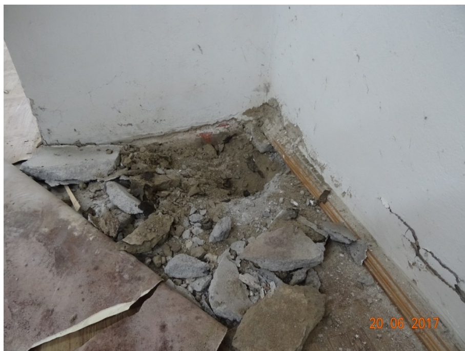
Fot. 71. Odkrywka jak na fot. 70, lecz stan po przekuciu podkładów. Widoczna izolacja pozioma na dwóch poziomach (pod nowym podkładem gr. 8 cm i pod 3 cm starym podkładem).
