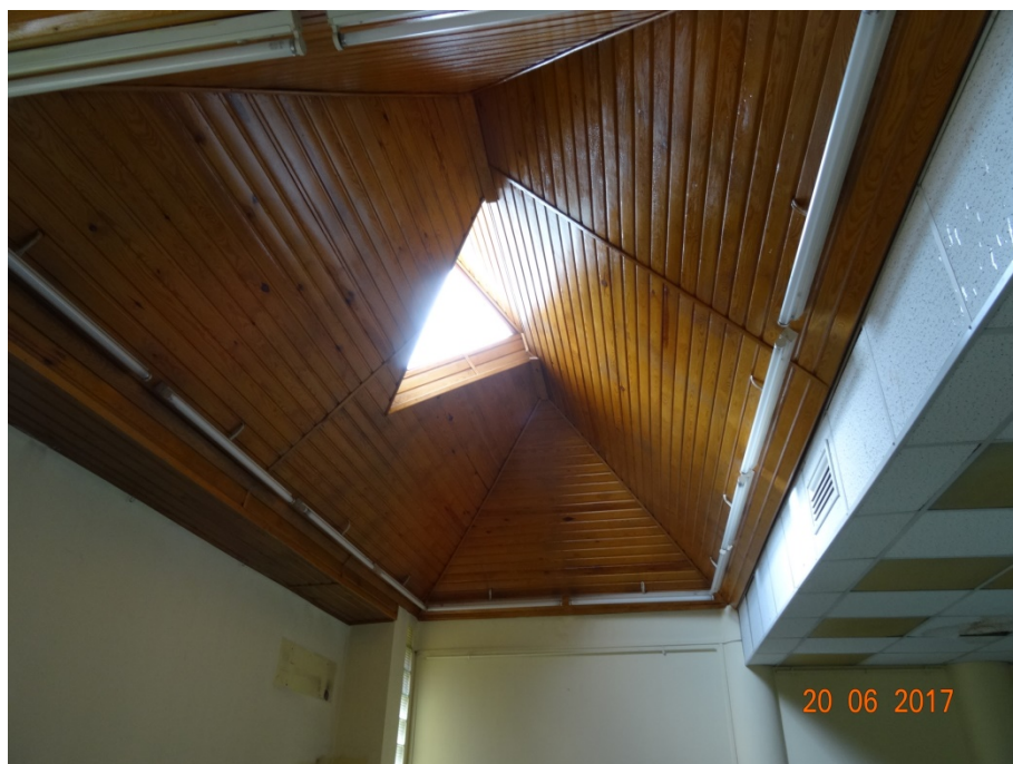
Fot. 99. Widok ogólny dachu w części z naświetlami.(dach stromy).
