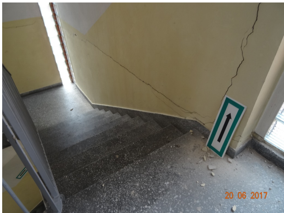
Fot. 108. Zarysowania poziome i pionowe ścian pn.-zach. między spocznikami pośrednimi.
