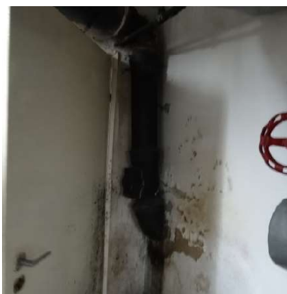
Fot. 64 i 65. Zawilgocenia w narożu przy drzwiach od strony tunelu.
