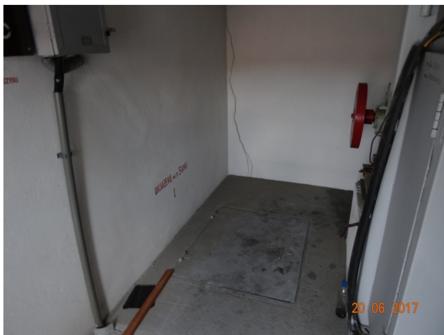
Fot. 91. Zarysowanie ściany maszynowni spowodowane oddziaływaniem dylatacji konstrukcyjnej budynku zasadniczego.
