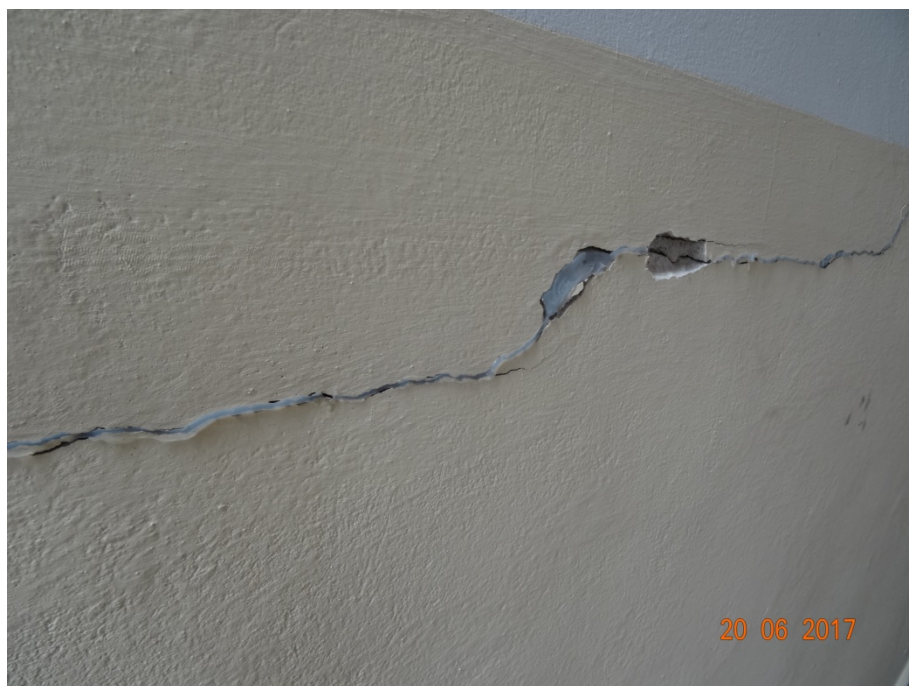
Fot. 109. Uszczelnienie pęknięć jak na fot. 108 silikonem.
