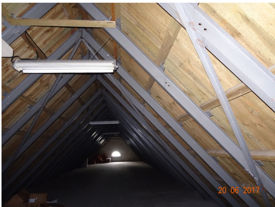
Fot. 93. Stalowa więźba dachowa na poddaszu nieużytkowym. Brak deformacji wskazujących na wadliwą pracę konstrukcji, brak również śladów zawilgoceń i korozji biologicznej płatwi i deskowania.
