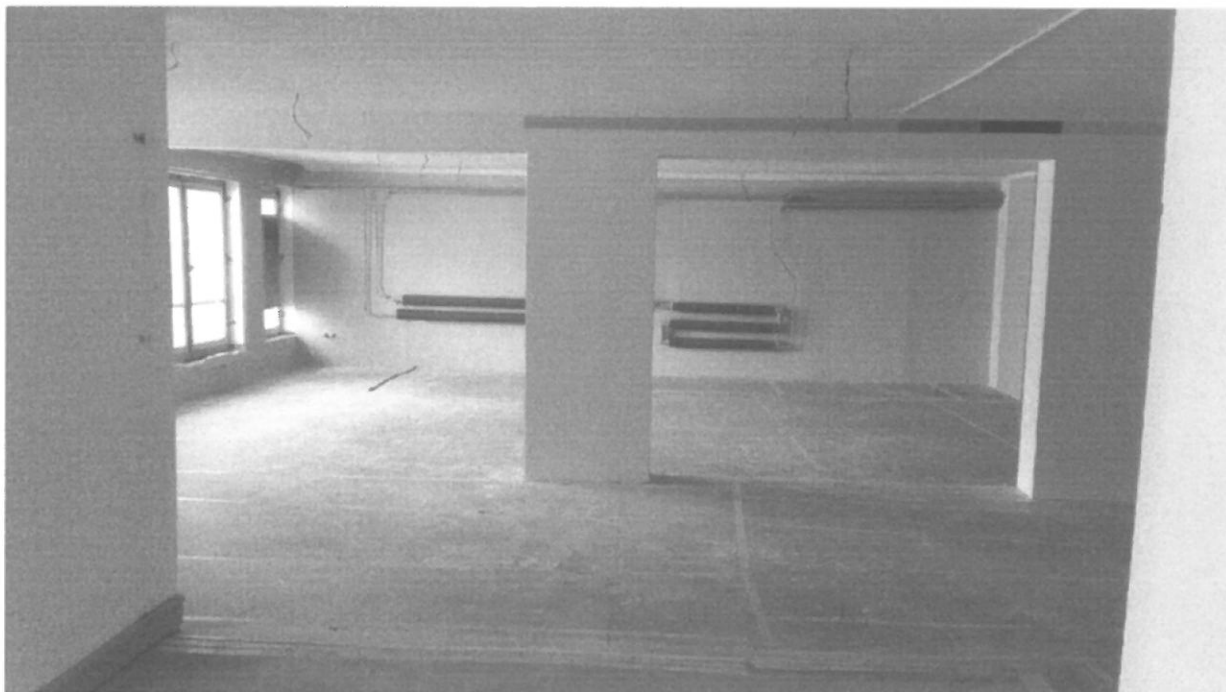
Fot. 3. Pomieszczenia biurowe na piętrze w północnej części budynku
