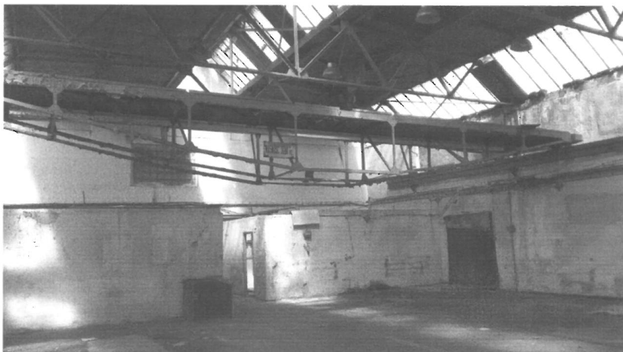
Fot. 4. Suwnica w południowej części budynku – funkcja produkcyjno-magazynowa.
