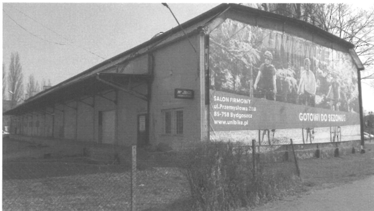
Fot. 1. Elewacja zachodnia i południowa
