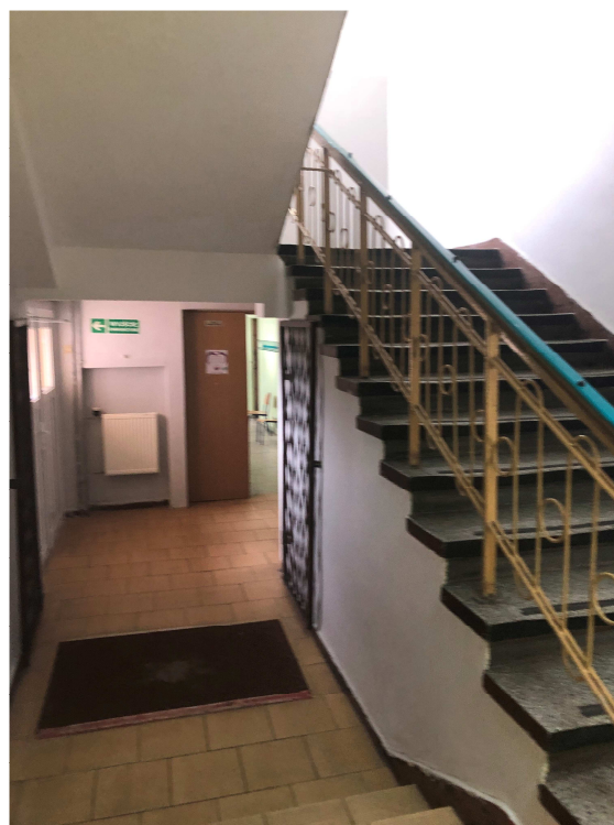
parter – klatka schodowa
