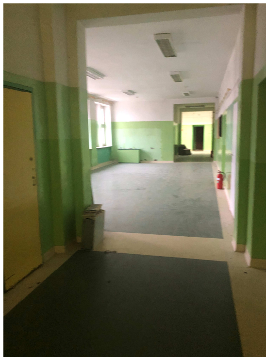
III piętro – korytarz
